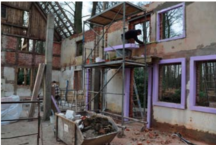
Befestigung der PU-Dämmschürzen um die Fensterleibungen
