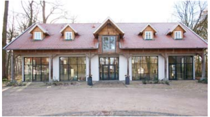
Um den offenen Charakter der Remise zu erhalten, bauten die Handwerker eine zurückversetzte verglaste Pfosten-Riegel-Konstruktion ein
