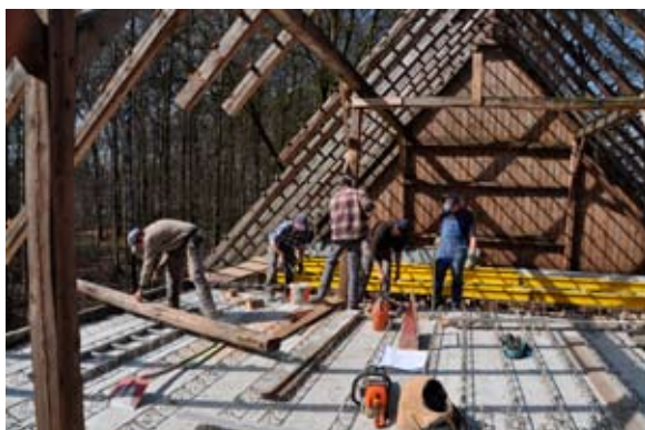
Die neue Stahlbetondecke wird betoniert
